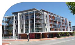
COMPLEJO RESIDENCIAL NORWOOD Australia
